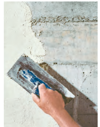
Als Haftputz wird UNI-H max. 3-5 mm stark aufgetragen und eben verzogen.
