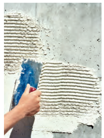
Zur weiteren Beschichtung mit Grundputzen wird UNI-H als Haftbrücke mit der Zahntraufel horizontal aufgezogen.
