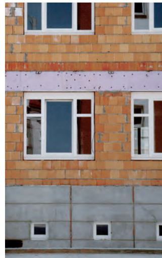
Betonfläche im Sockelbereich.
