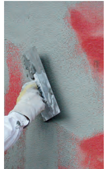
Als Armierungsputz mit Gewebeeinlage zur Fassadenüberarbeitung oder auf Leichtunterputzen.
