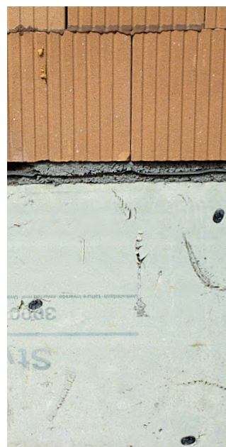
UNI-H als Haftbrücke auf XPS-Platten (Styrodur).
